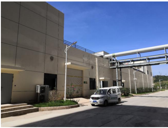
渗滤液处理站
